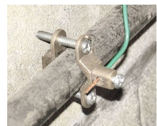
Pic. 6.3.1 Equipotential bonding
