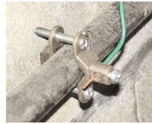
Pic. 7.0.1 Equipotential bonding
