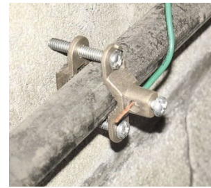
Foto. 6.3.1 Equipotential bonding
