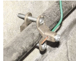
Foto. 7.0.1 Equipotential bonding
