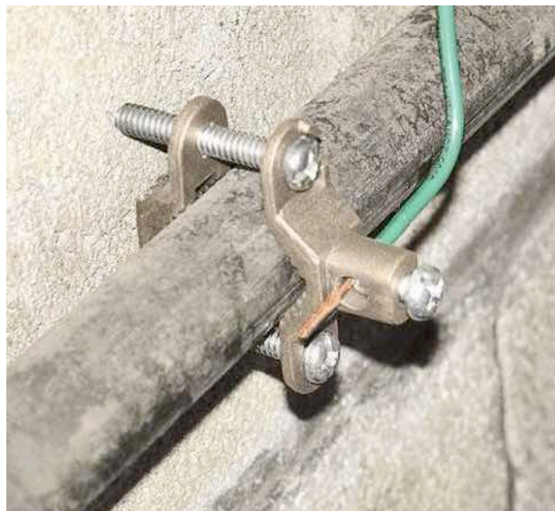
Pic. 7.0.1 Equipotential bonding
